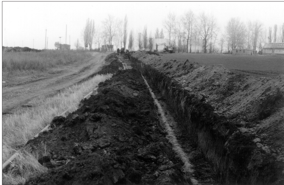
Рис. 25. Перещепине I. Траншея газоконденсатопроводу, що перетнула поховання №№ 1-5/2000 р. З південного сходу.
