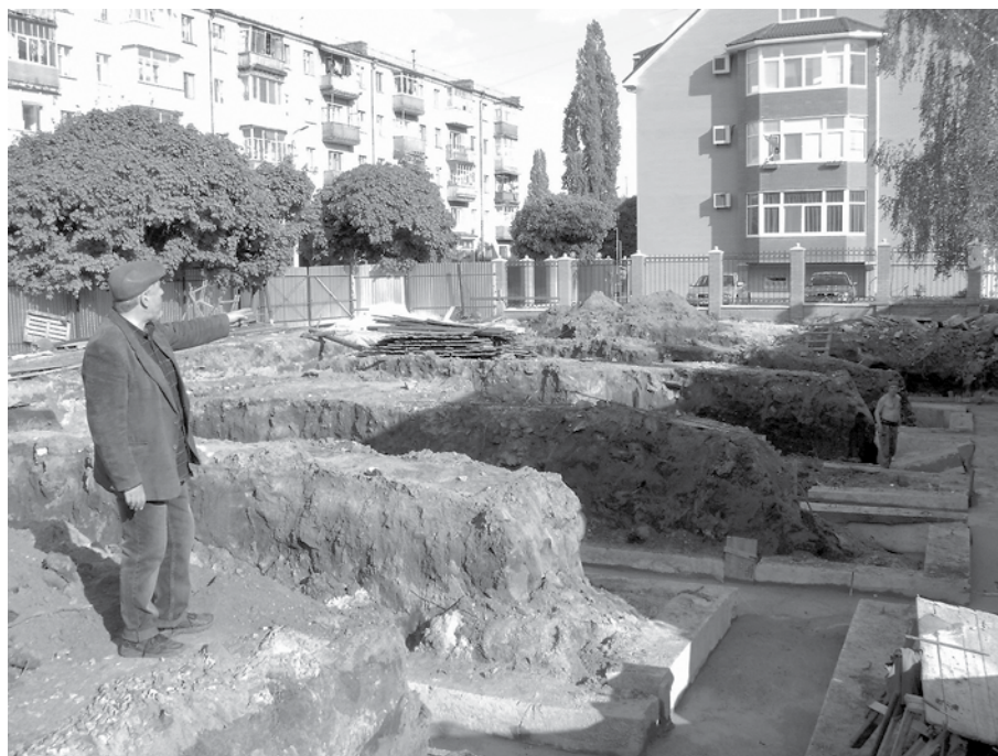
Рис. 10. Кременчук, м., вул. Генерала Жадова, 1в. Котлован на місці спорудження жит- лового будинку, 2006 р. З північного заходу.
