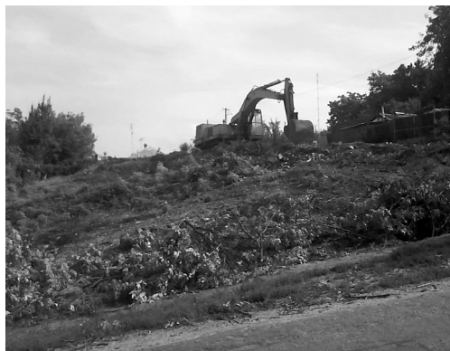
Рис. 65. Коперника, пров., 6. Ділянка будівництва. З північного сходу.
