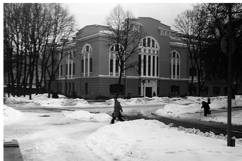
Рис. 30. Відреставрований фасад старого корпусу НБУ (вул. Жовтнева, 17). На передньому плані – місце початку траншеї 1.
