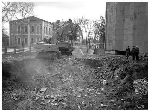
Рис. 55. Початок вибирання котловану. Зі сходу – південного сходу.
