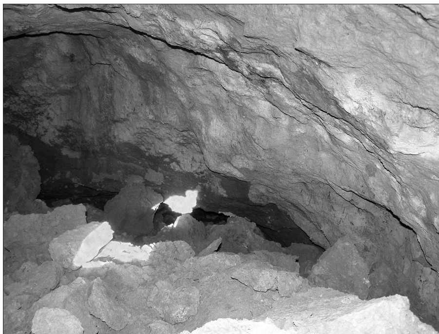
Рис.77-78. Провал підземного ходу. Склепіння у материковому суглинку та завали.
