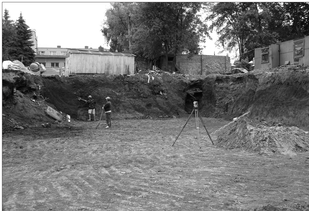
Рис.84. Котлован будівництва. Зачистки північно- та південно-західного профілів.
