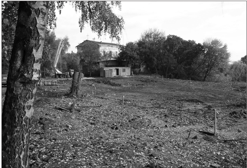
Рис. 9. Ділянка спорудження котловану, очищена від решток забудови. На задньому плані — Миколаївська церква (добудова сер. XIX ст.). Помітний перепад висот з північного заходу на південний схід та в широтному напрямку, в бік Мазурівського яру. Вигляд із заходу.
