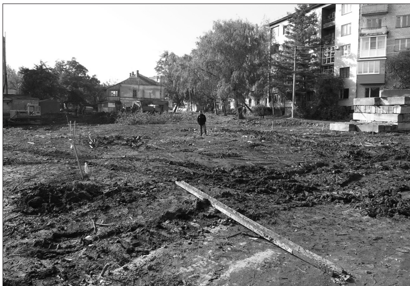
Рис. 10. Місце спорудження котловану, очищене від решток забудови. На задньому плані — будинок по Першотравневому пров., 9/1, де народився А.В. Луначарський (третя чверть XIX ст.). Помітне підвищення ділянки у західний та північно-західний бік. Справа — житловий будинок по Першотравневому просп., 13-А. Вигляд зі сходу.
