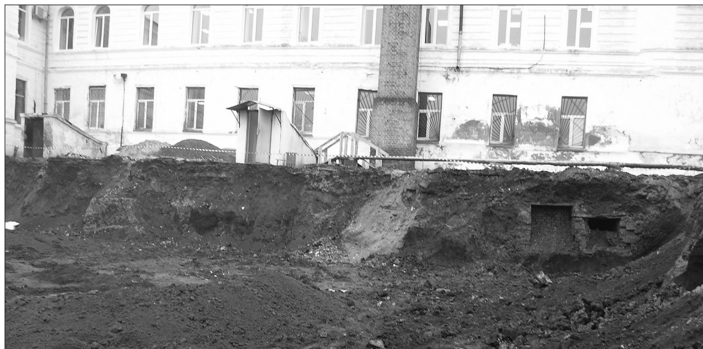
Рис. 12. Першотравневий просп., 19-А. Південно-західний профіль стінки котловану будівництва. Вигляд зі сходу.
